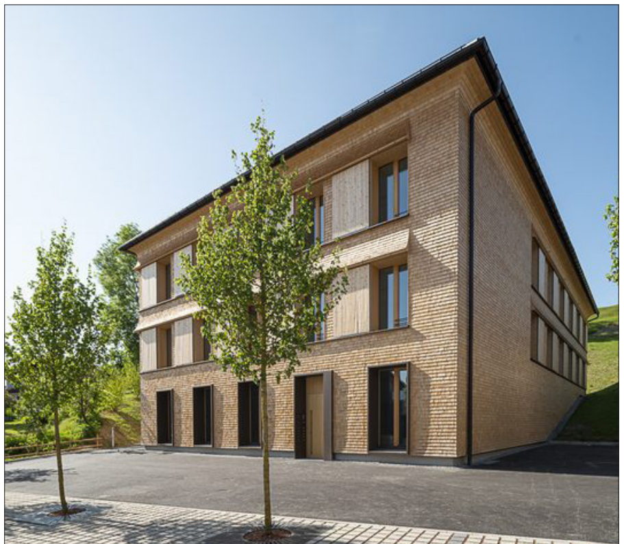
Therapieräume, Büroflächen und vier Wohneinheiten – Heizung nicht notwendig
