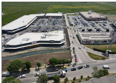
Das Fachmarktzentrum in der rumänischen Stadt Vaslui ist das fünfte Projekt, das von dem polnischen Unternehmen Scallier entwickelt wurde.
