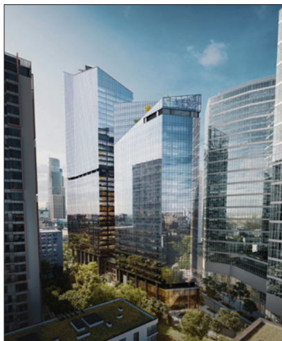
Der Hochhauskomplex Skyliner am Rondo Daszyńskiego in Warschau besteht aus zwei Hochhäusern, Skyliner I und Skyliner II. Skyliner I wurde Anfang 2021 fertiggestellt, Skyliner II ist im Bau.
